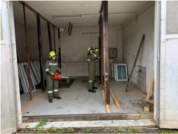
Das Pölzen eines gefährdeten Gebäudes funktionierte bestens
